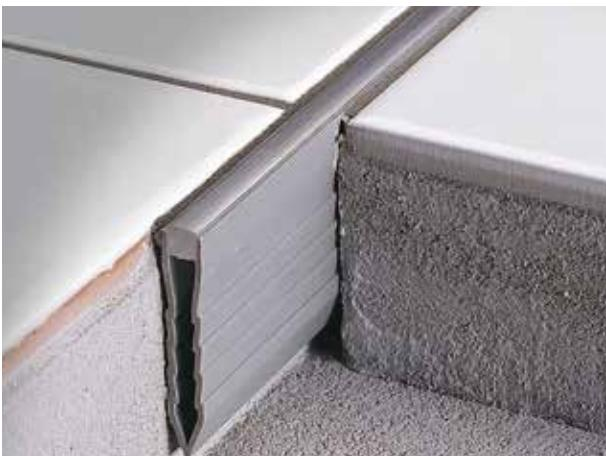
Giunto di frazionamento in materiale sintetico per posa a malta. Ideato per frazionare aree piastrellate di grandi dimensioni in zone più piccole, offre una limitata protezione al bordo del rivestimento. Compensa piccoli movimenti dovuti alla dilatazione dei materiali di supporto, ma esclusivamente in compressione o scorrimento. Situazione di applicazioni tipiche: negozi, aree ricreative come hotel, centri sportivi e scuole.
